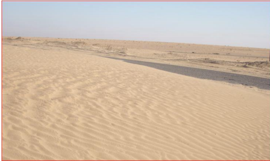
صورة (١) زحف الرمال على طريق بيجي- صينية التقطت الصورة بتاريخ ٢٠١٨/٦/١٧
